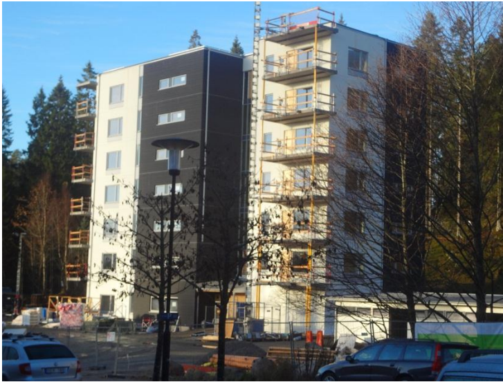
Bild 1 Passivhus med sandwichelement i betong under produktion vinter 2012/2013.
