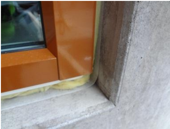
Bild 12 I ett besökt objekt har ett skydd mot inträngning av vatten in i sandwichelementet under byggtiden monterats. Detta skydd är på den aktuella byggplatsen kvarsittande även efter montage av fönster.
