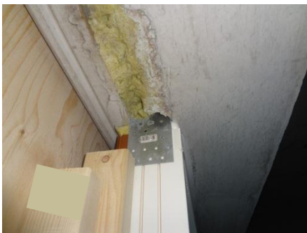
Bild 11 En köldbrygga uppstår då ett infästningsbleck monterad mellan yttre och inre betongskivan (se kapitel 4.4.2).
