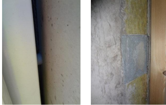
Bild 4 Två olika infästningar av fönster. Till höger syns den plåtdetalj som används för infästning av fönsterkarm och som är genomgående mellan den inre och den yttre betongskivan.
