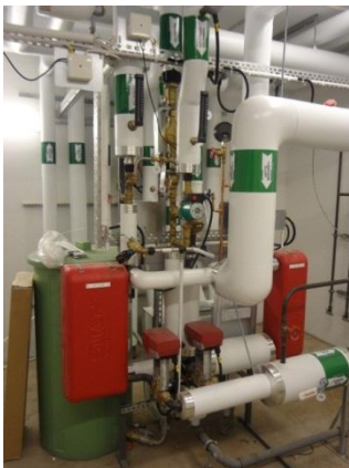
Bild 13 Centralt beläget apparatarum för värmeåtervinning.
