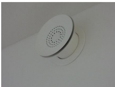
Bild 7 Tilluftsventil i en byggnad med mekanisk till- och frånluft med värmeåtervinning (FTX)
