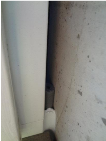
Bild 6 Den invändiga fogningen har påbörjats runt en fönsteranslutning.
