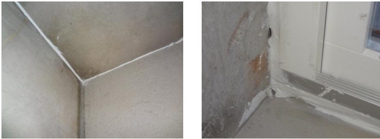
Bild 5 Vid tunga klimatskal i betong är lufttäteten beroende av täthet i skarvar och anslutningar som är exponerade från insidan. Liksom för allt arbete med lufttätet är det även här viktigt att detaljer blir utförda väl, att t ex fogmassan täcker hela skarven.
