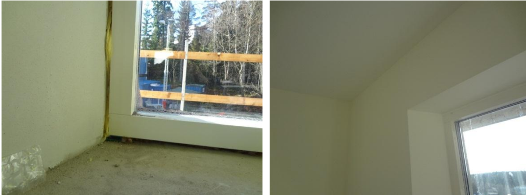
Bild 9 Lufttäteten vid tunga klimatskal sker framförallt från insidan, exempelvis vid fönsteranslutningar.
